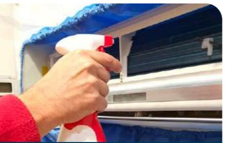
Pulizia batteria senza telo di protezione
