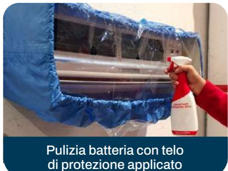
Pulizia batteria con telo di protezione applicato
